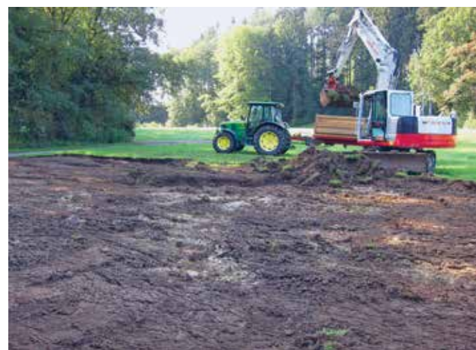
En haut: verdissage direct après décapage du sol sur l'Itzikerriet, à Grüningen (ZH). En bas: décapage des couches supérieures du sol sur le Pünt, à Grüningen (ZH). Photos Daniel Kreiner
